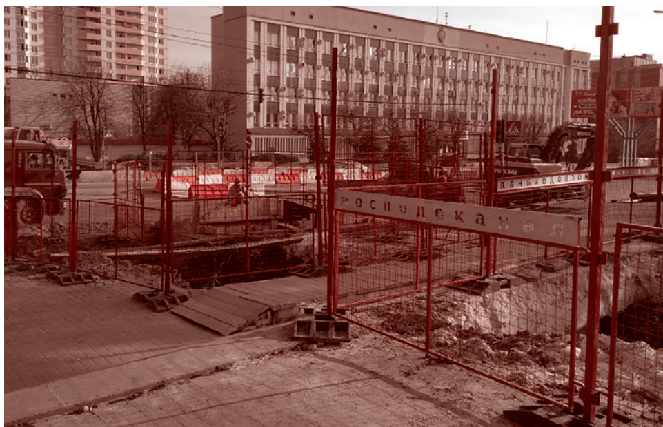
Ограждения ремонтных работ от коммунальной службы «Мосводоканал»
