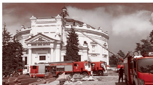
Пожар в здании Панорамы Севастополя
