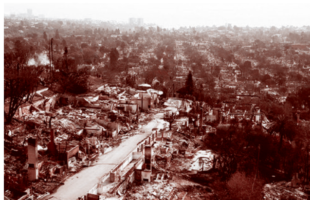
Дома, разрушенные пожаром в районе одноэтажной застройки Пасифик-Палисейдс. Лос-Анджелес. США
